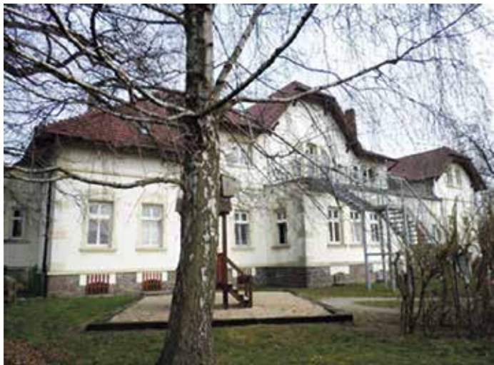
Mehrfamilienhaus – Hauptstraße 10 in 39596 Hohenberg-Krusemark
