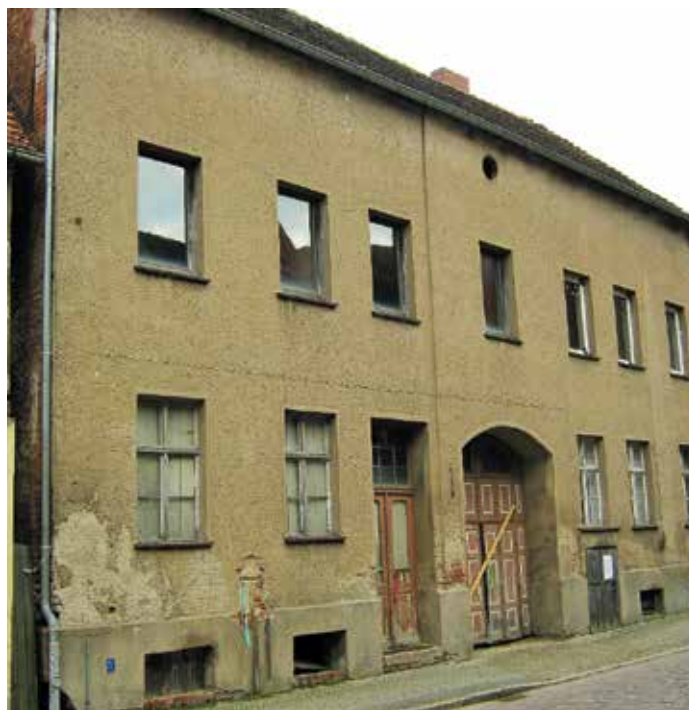
Wohn- und Geschäftshaus – Marktstraße 6
